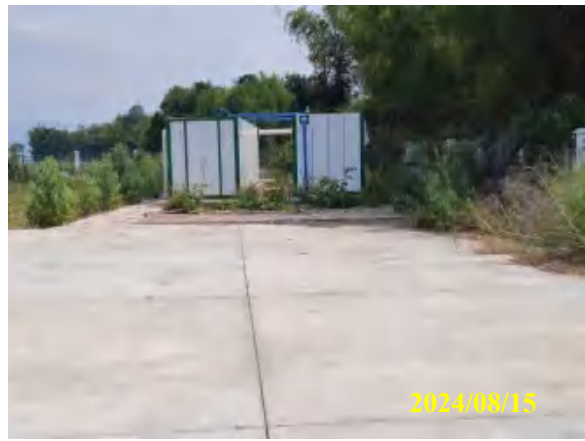
污水处理站西侧现状
