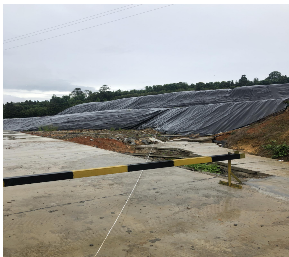
项目区东北侧垃圾填埋场
