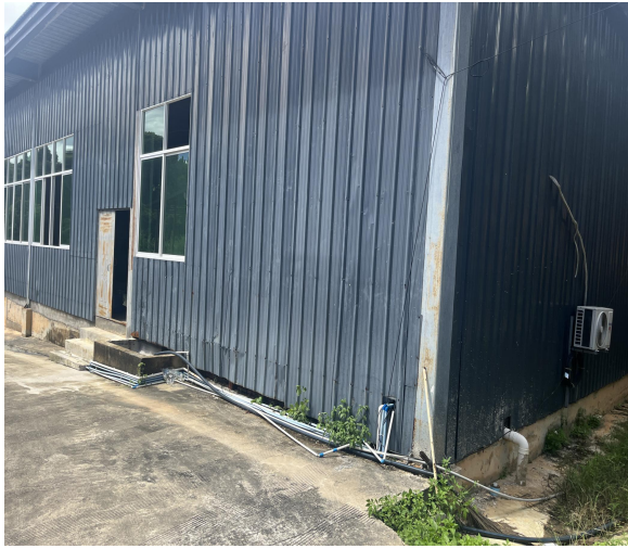
渗滤液处理车间
