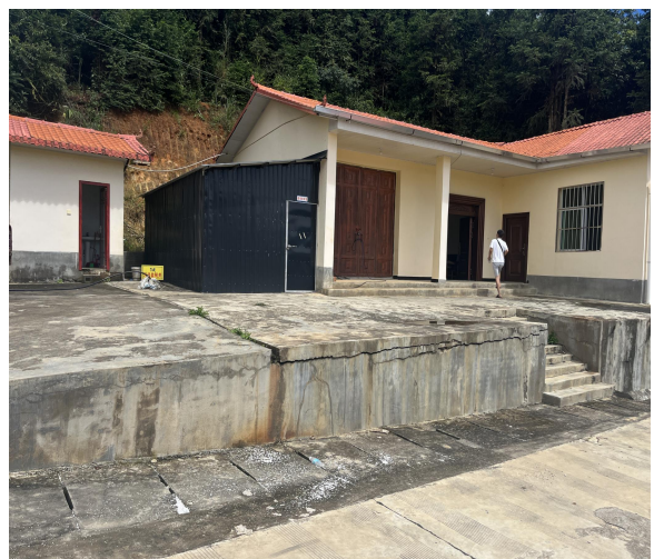
在线监测废液暂存间
