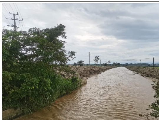
3#南撒河治理终点
