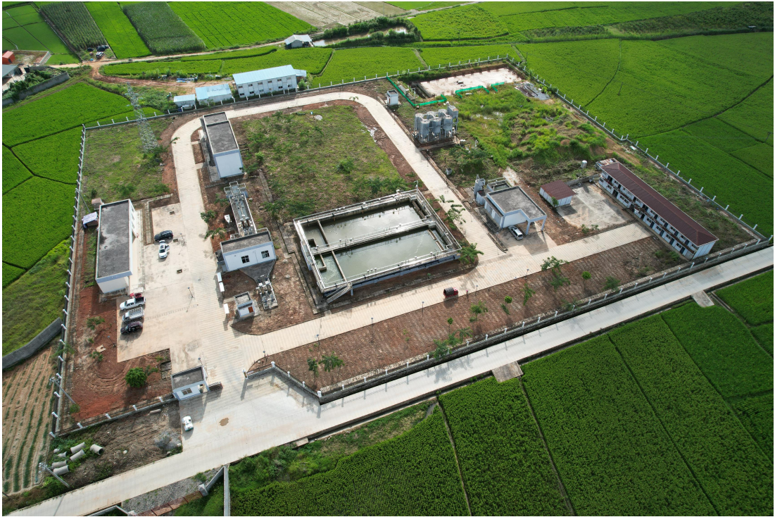
图 3.1.2-1 厂区现状照片
