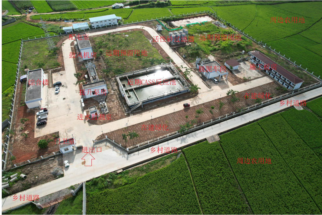
图 3.1.2-1 厂区现状照片
