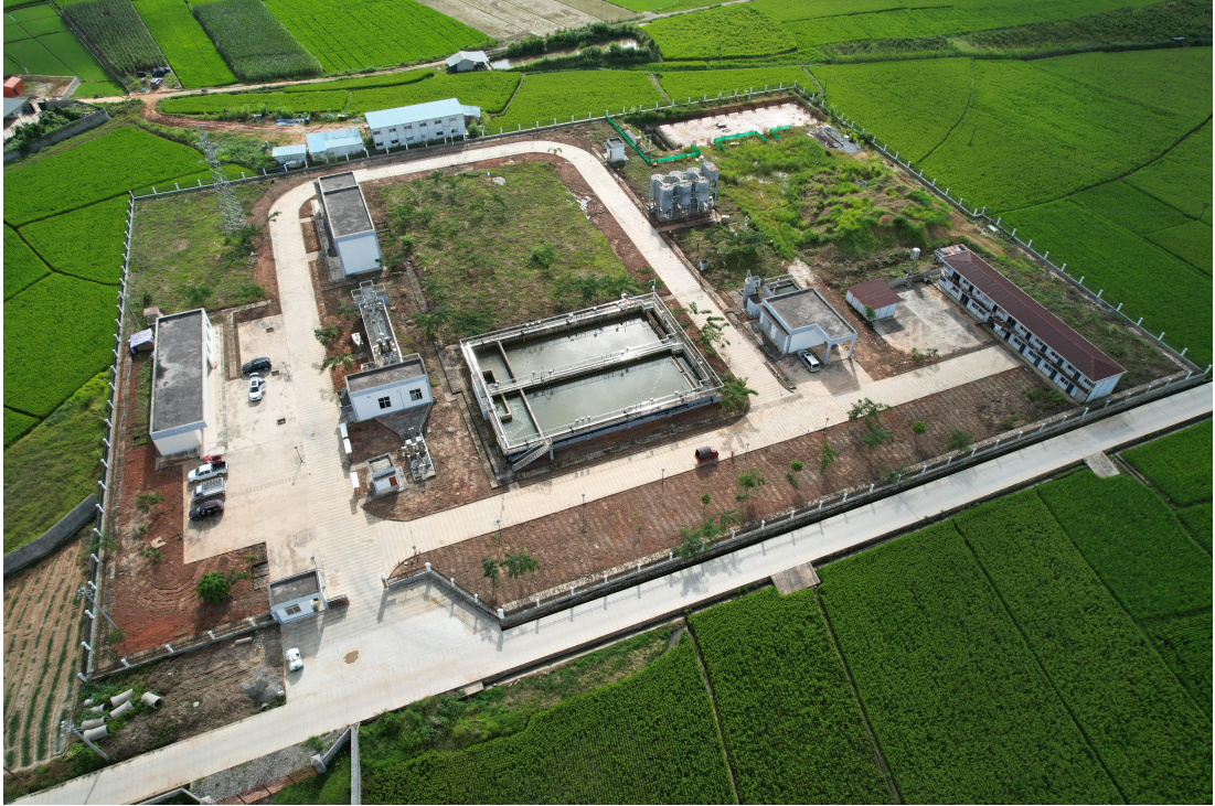
图 3.1.2-1 厂区现状照片
