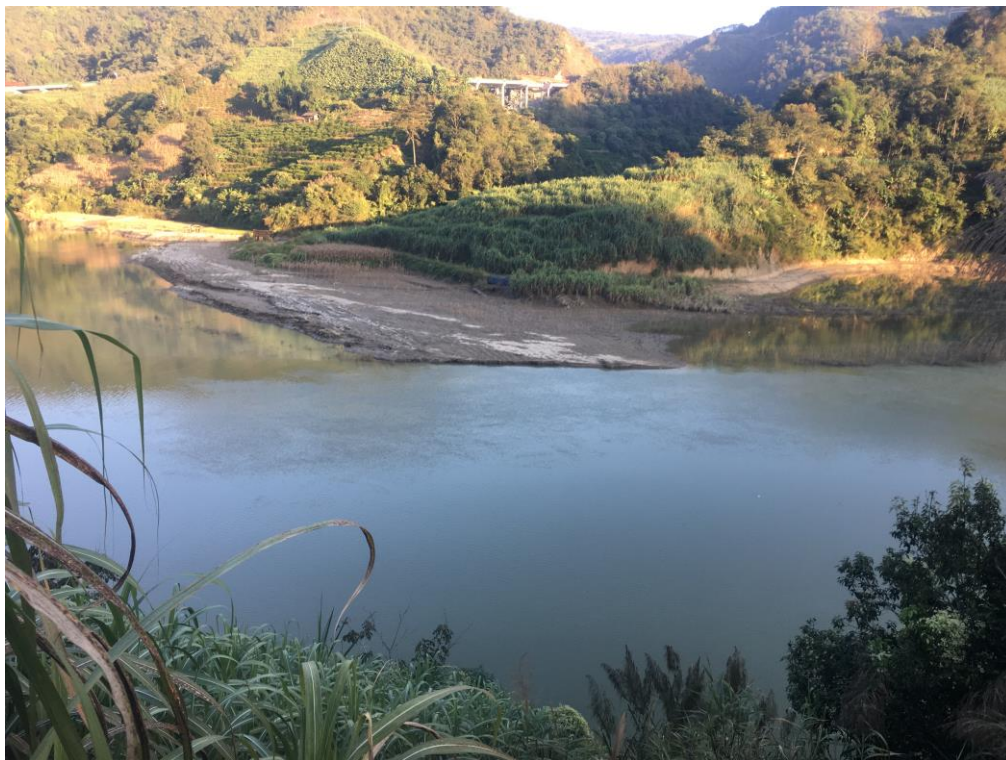
照片 6-8 KC-07 龙江龙江特大桥~冒线渡口段（库区）
