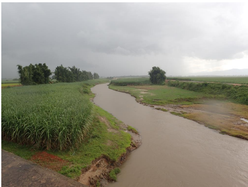
照片 3-2 南宛河堤防工程临水侧边滩
