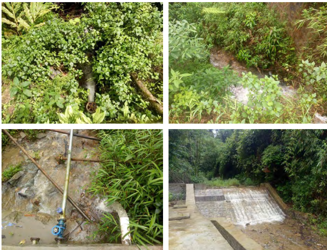
图 2.5-1 取水口、取水坝、输水管道现状
