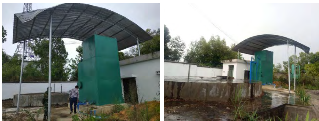
图 2.5-2 勐约乡自来水厂现状
