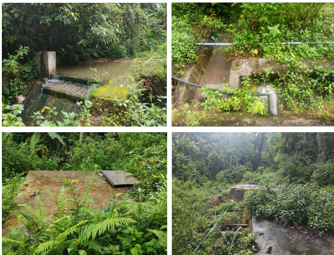
2.5-1 勐约乡崩龙河取水口及沉沙池现状
