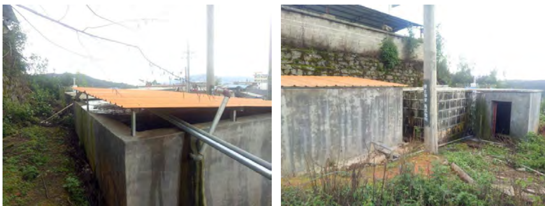
图 2.5-2 护国乡配水房现状
