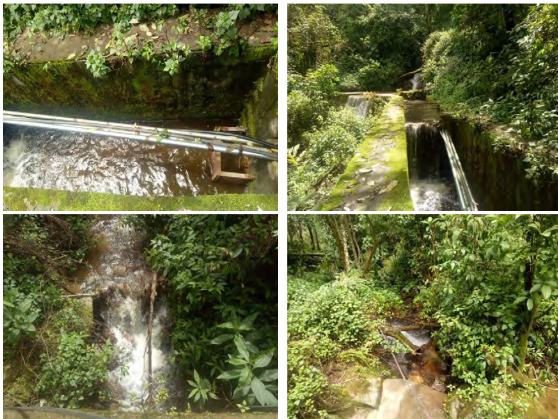
图 2.5-1 取水口及沉砂池现状
