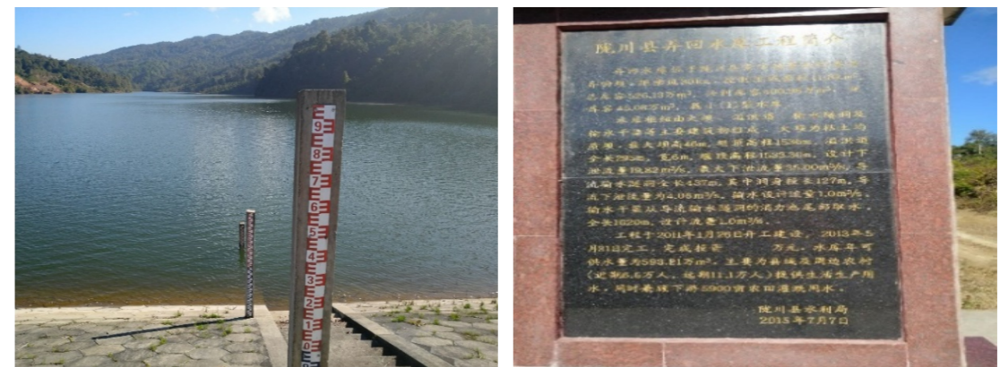
图 2.3-7 弄怀坝水库水位标尺及介绍牌
