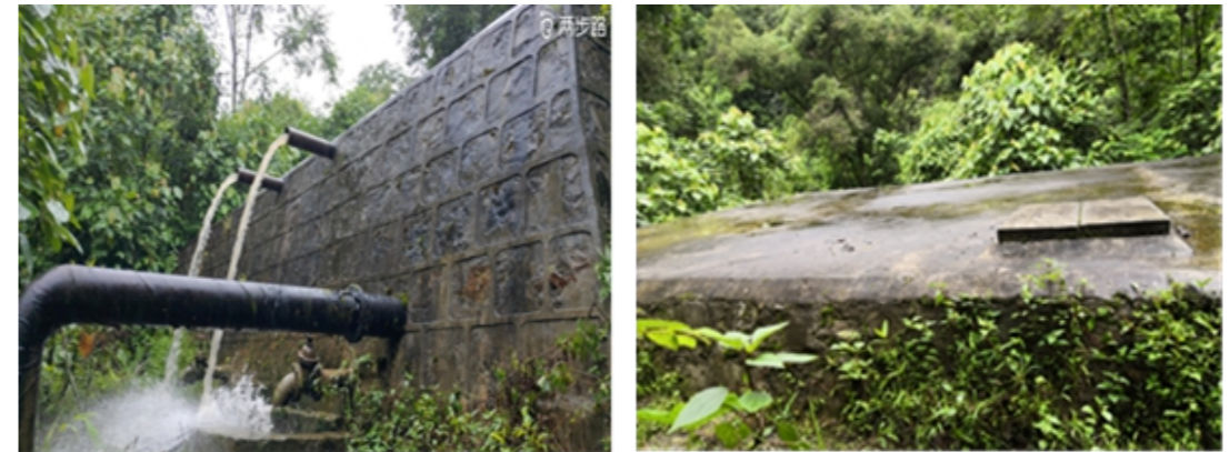
图 2.3-10 城子镇曼冒村河流型水源地取水口及沉沙池现状
