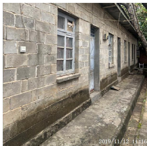
项目区宿舍及雨水沟
