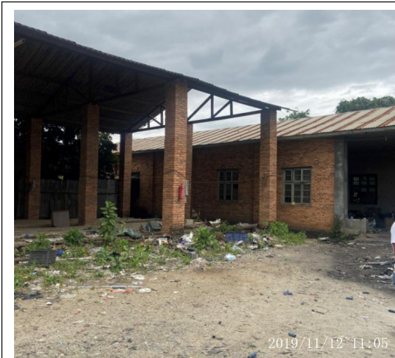
项目区现有建筑
