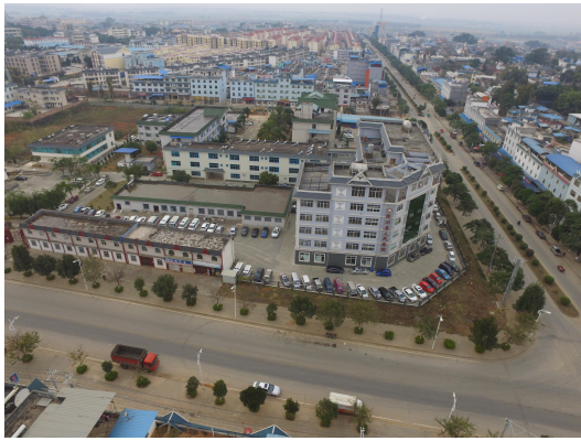
项目北侧及东侧
