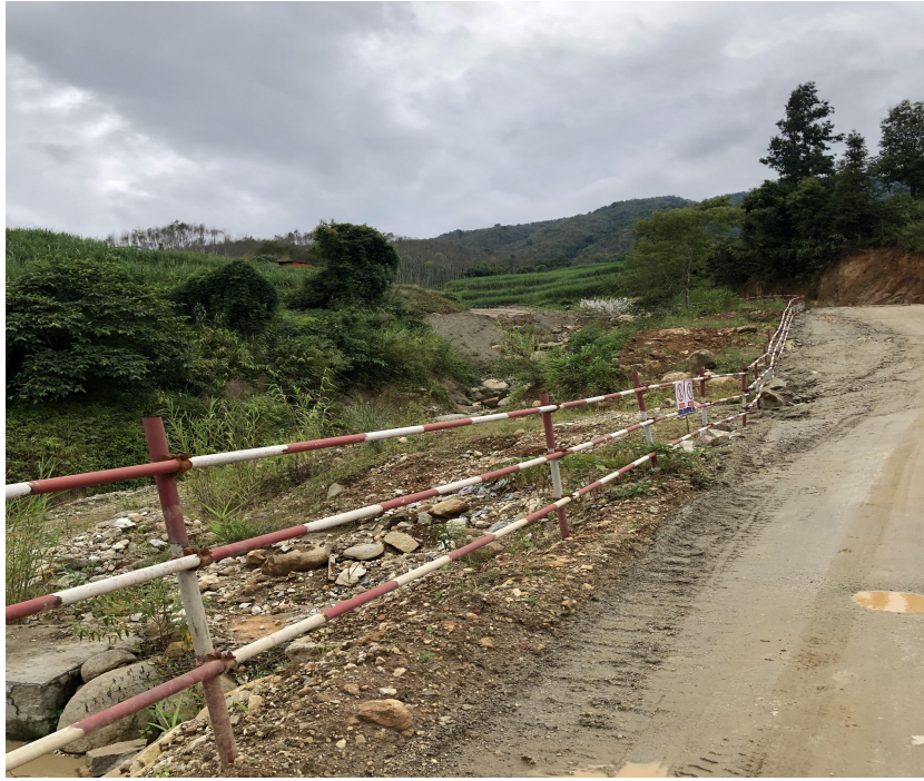
图 6: 原泥石流与南民河交汇处上游 20m 左右有一座水库建设单位修建的施工便道桥, 从桥上可以看到径流内部的石块及淤泥清理情况。
