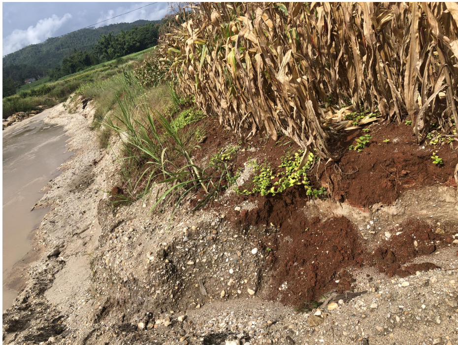
图 15：河道两侧 15m 范围内农田均覆表土大于 30cm 保证农田生长。
