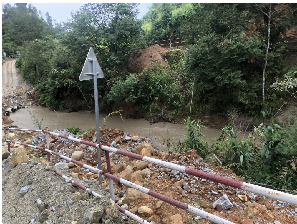
图 10：南民河上游（与 2013 年泥石流无关上游河道），水库建设公司的施工便道及栏杆警示牌，可以明显对比上游河道与清理后的中下游河道的清理效果。
