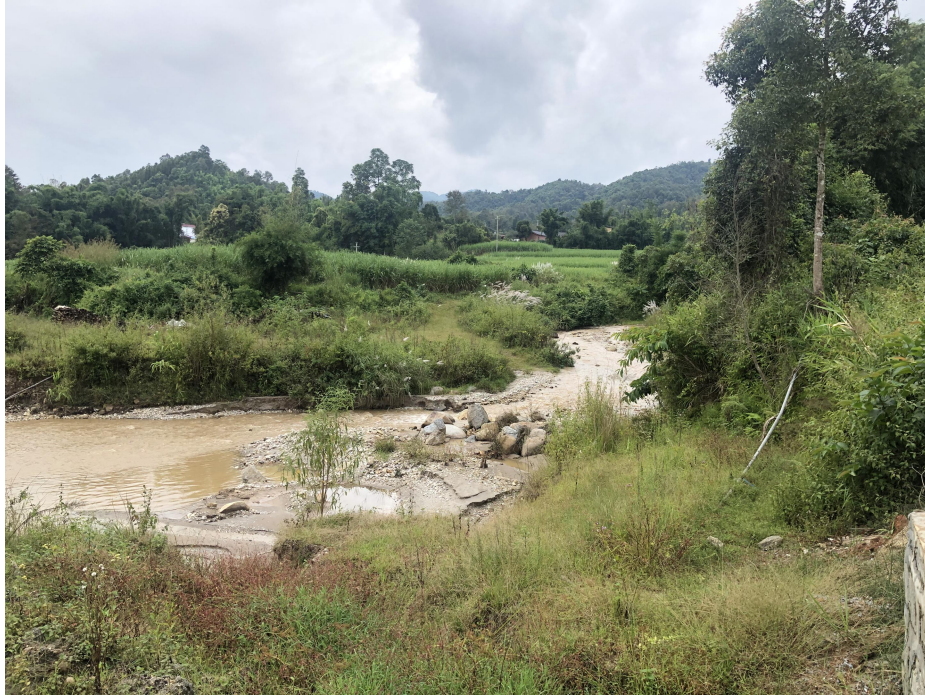
图 1：下游河道清淤后现状，两边植被恢复良好，河道已经到达原来的深度，河道通畅，无明显的矿山废渣在岸边淤积。
