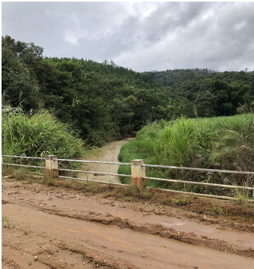
图 7: 此处从施工便道桥另一侧往上游至建设中的水库的河道照片, 与 2013
