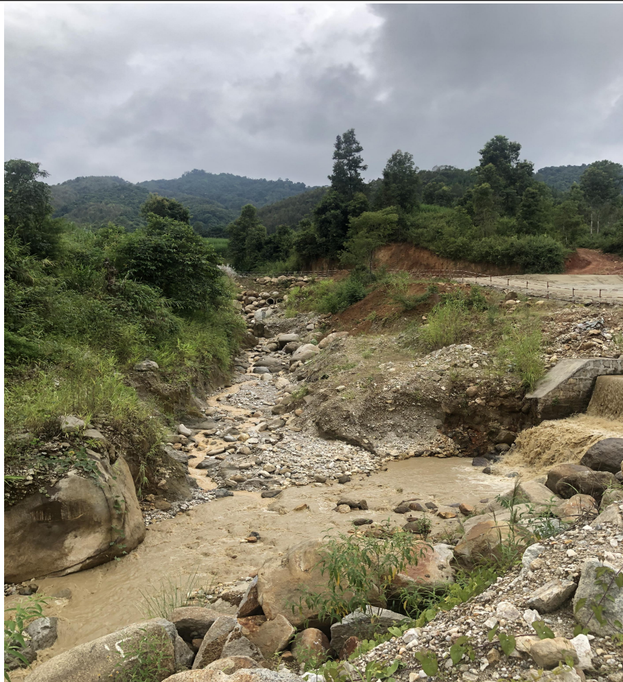
图 5：此处是 2、3 号矿区发生泥石流后汇入南民河处，照片中能清晰看到中间位置是之前泥石流冲刷出的地表径流痕迹（据业主介绍，泥石流发生时此处淤泥堆积高约 3m，完全堵塞南民河上游来水），目前从泥石流径流汇入口到拦渣坝的所有淤泥已经全部清除完毕，从南民河上游（图中右侧来水）正在新建的水库来水完全通畅至中下游。
