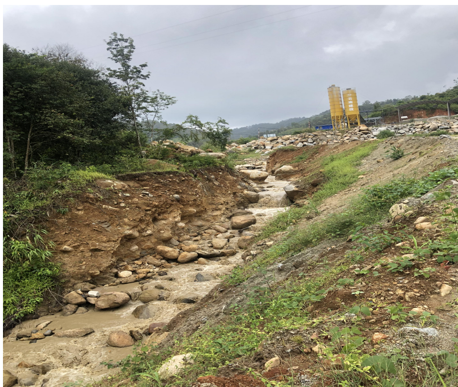
图 11：新建水库泄水口施工现场，位于与原泥石流交汇处上游约 3km。
