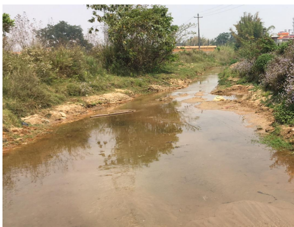
南伞河部分治理河段现状
