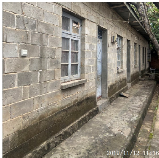
项目区宿舍及雨水沟
