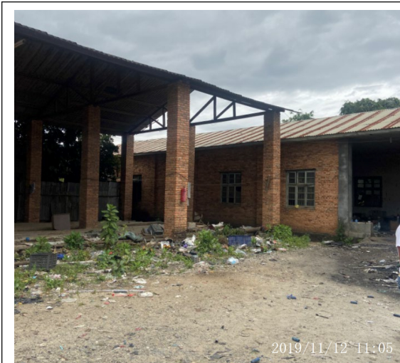
项目区现有建筑
